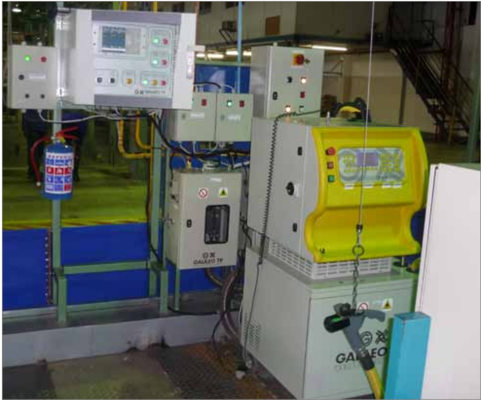
Figura 17: Sistema de bombeo en zona de evacuación
