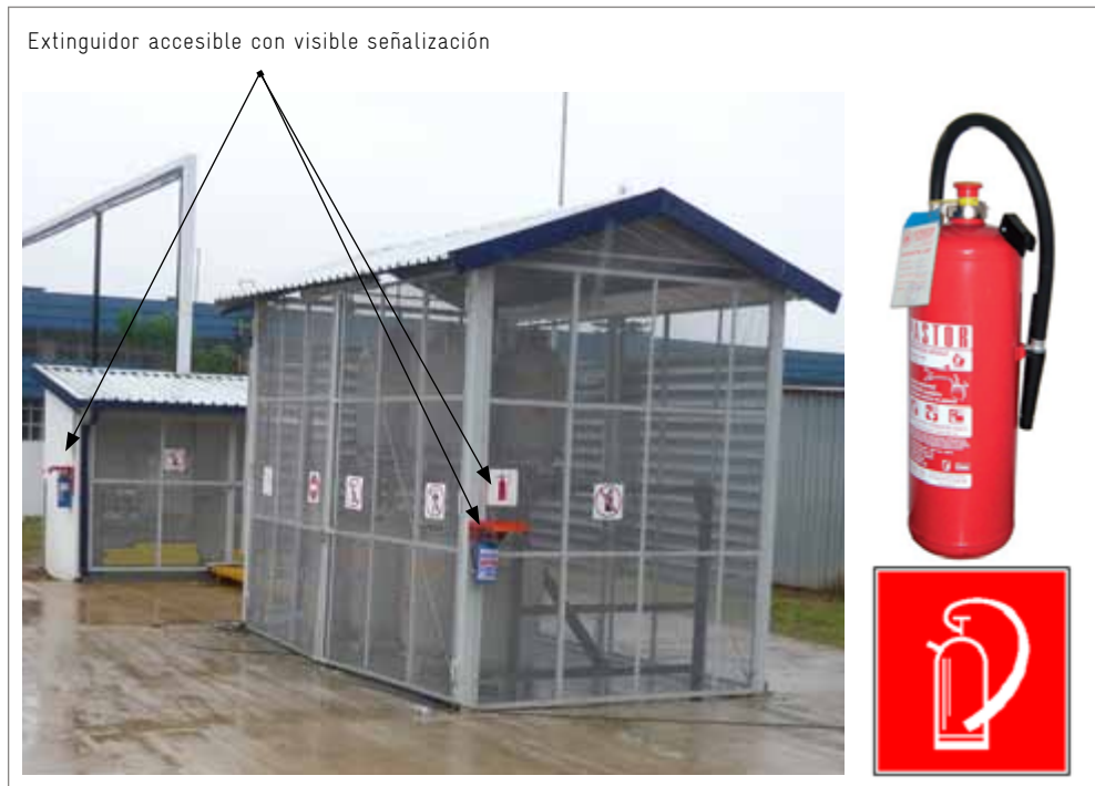
Figura 10: Protección contra incendio para almacenamiento de HC en exterior
