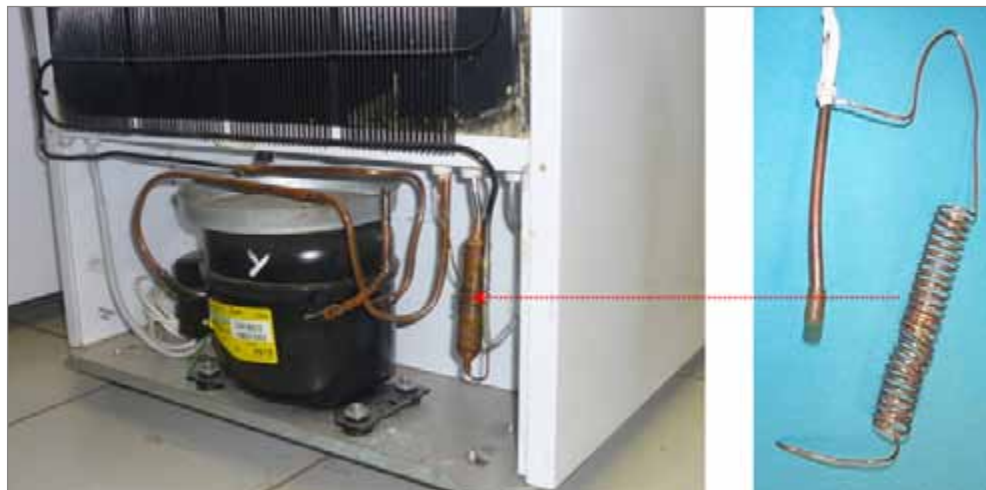
Figura 27: Tubo capilar
