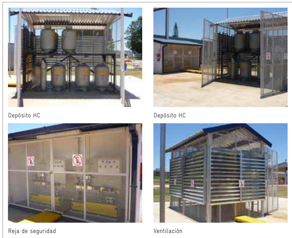
Figura 8: Cobertizo de almacenamiento de HC
