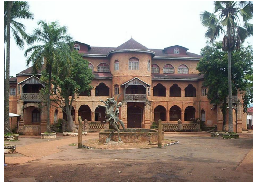
Palais Bamoun construites en briques cuites
