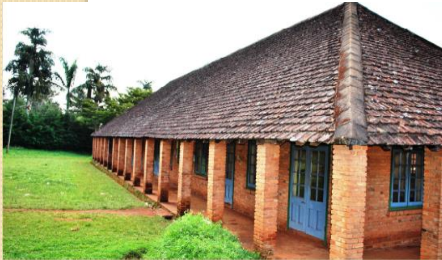
Bâtiment colonial construit en briques cuites
