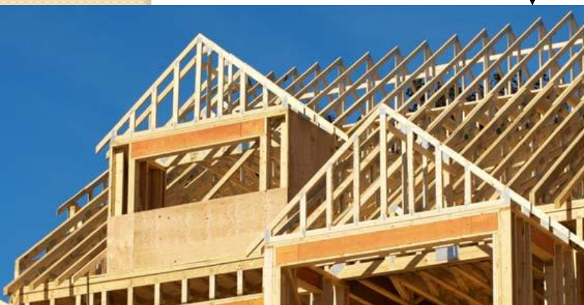
Charpente en bois
