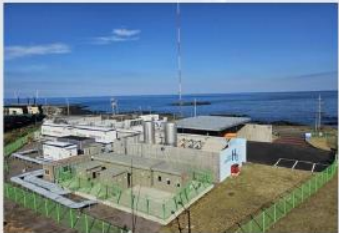
3.3MW 그린수소 생산시설
