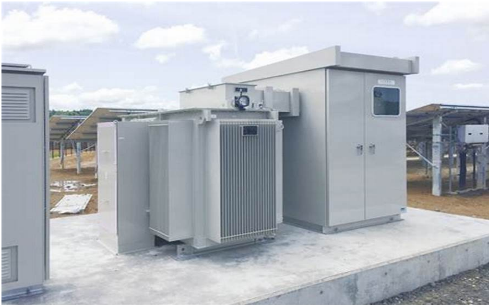
Figure 44- Poste de transformation préfabriqué (H59)
