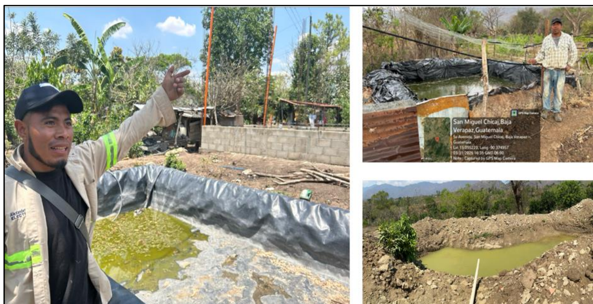
Figura 14. Huecos revestidos con geomembrana, nylon y no revestido para almacenamiento de agua para riego.
