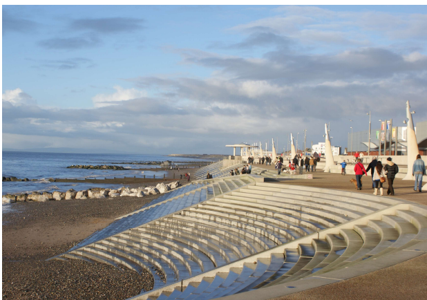
Sistema de protección costero de Cleveleys, Reino Unido. Fuente: Wyre Council
