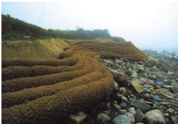
Proceso de estabilización de un talud en Massachusetts. Fuente: New England Environmental.
