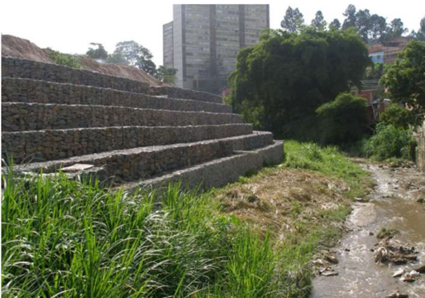
Estabilización de los márgenes del Río San Pedro, Los Teques, Venezuela. Fuente: EcoGreen Construcciones.
