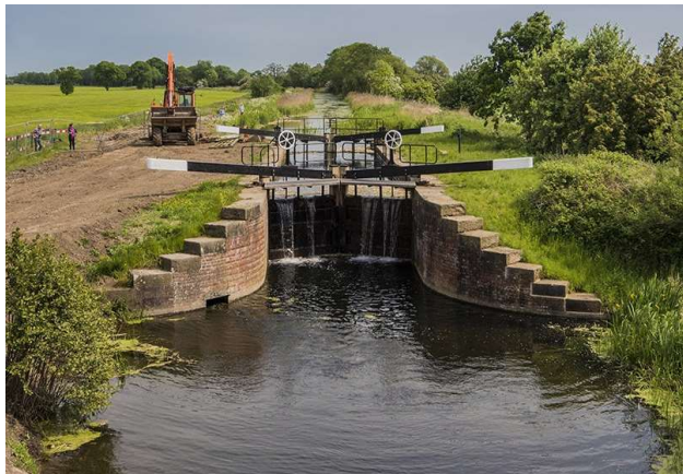
Compuertas en Bekhamste, UK. Fuente: River Trust.org
