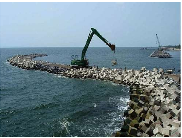
Construcción de un dique. Fuente: DMC.
