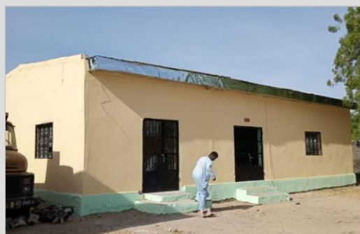
Photo 22 · Bâtiment à Pette pour le stockage du lait après réfection
