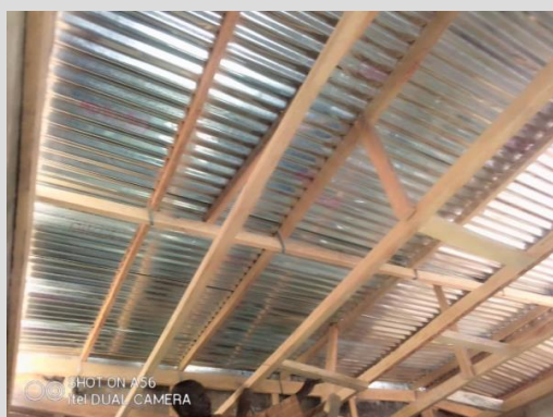
Photo 8 · Toiture refaite (pour supporter les panneaux solaires). Réfection de la toiture du Bâtiment temporaire de Petté pour bien supporter les panneaux solaires
