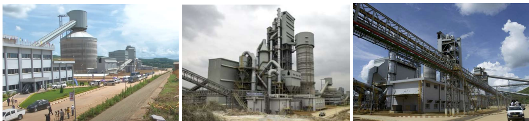
Figure 32 – (L) vue latérale silo à clinker et broyage du ciment, (M & R) tour PH/PC et ligne de four
