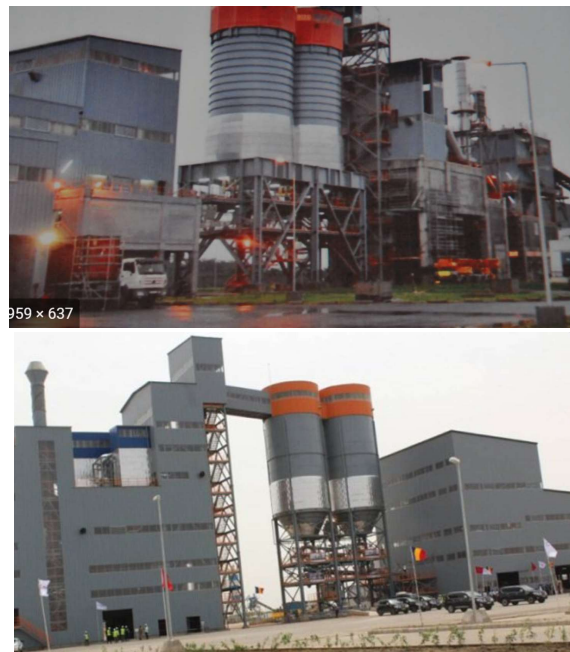
Figure 28 – vues latérales de l'installation CIMAF (côtés opposés)
