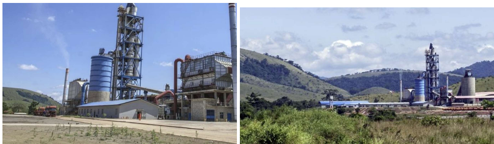
Figure 39 – Installation de production intégrée de FORSPAK près de Dolisie (diverses vues). Notez les émissions de particules provenant de la cheminée d'échappement du four/broyeur brut (post-précipitateur)
