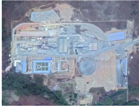
Figure 36 – Installation de production intégrée de FORSPAK près de Dolisie
