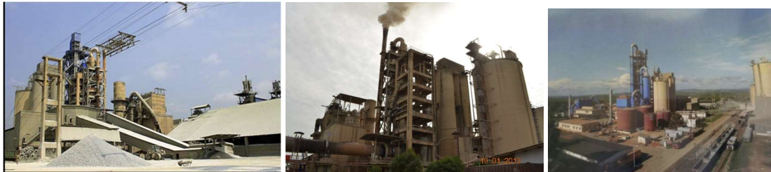
Figure 41 – Installation de production intégrée SONOCC près de Loutété (L) ligne de production existante 1965/2011 (R) Nouvelle ligne de production 2015
