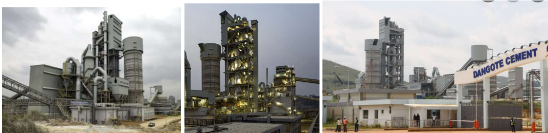
Figure 31 – (L & M) PH/PC, broyeur brut et silo à farine, (R) vue générale de l’usine (depuis l’entrée)
