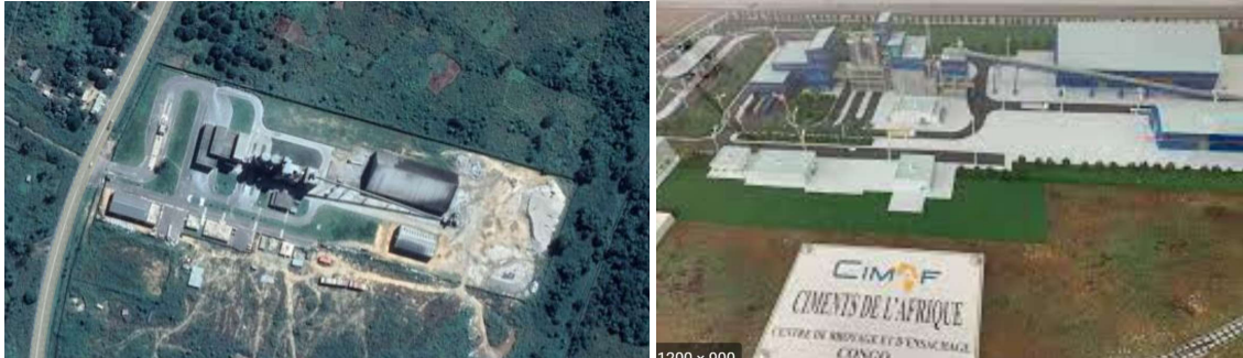
Figure 27 - (L) vue aérienne du site de l'usine près de Makola, (R) modèle 3D de la facilité CIMAF
