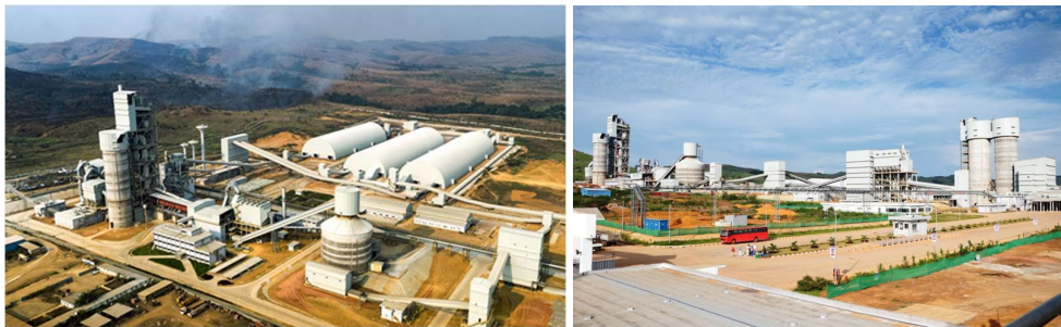
Figure 30 – Aperçu général de l’usine
