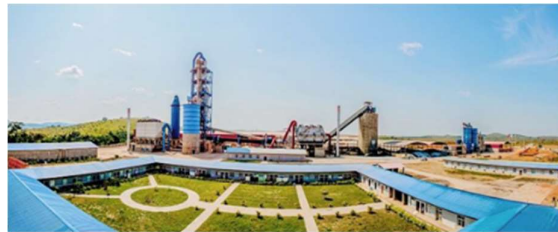
Figure 37 – Installation de production intégrée de FORSPAK près de Dolisie
