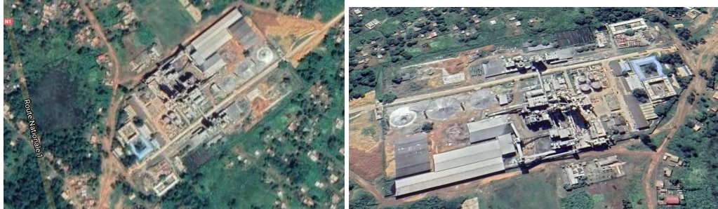
Figure 40 – Installation de production intégrée SONOCC près de Loutété (Nouvelle ligne de production)
