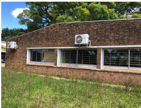
Figura 16. Ubicación del actual sistema de aire acondicionado en la escuela
