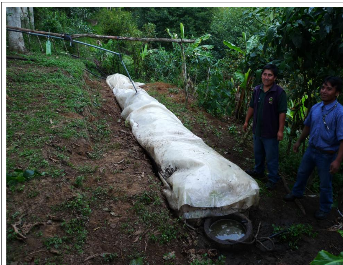
Figura 3 Biodigestor tubular plástico (con un plástico protector por encima) instalado en el Valle de Intag por la ACAI en 2013 (Imbabura)
