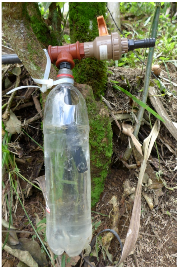
Figura 1: Arriba, esquema de la válvula de alivio. Abajo: fotografía de una válvula de alivio construida con una botella de refresco. En este caso la conducción de biogás acaba en la llave de la derecha, faltando su continuación hasta el lugar de consumo de biogás
