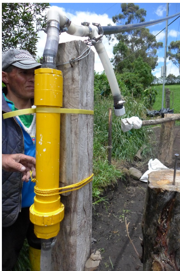
Figura 3: Arriba, esquema de filtro de ácido sulfhídrico y purga de agua posterior. Se corresponde con la fotografía donde se muestra un filtro de la empresa Biobolsa.
