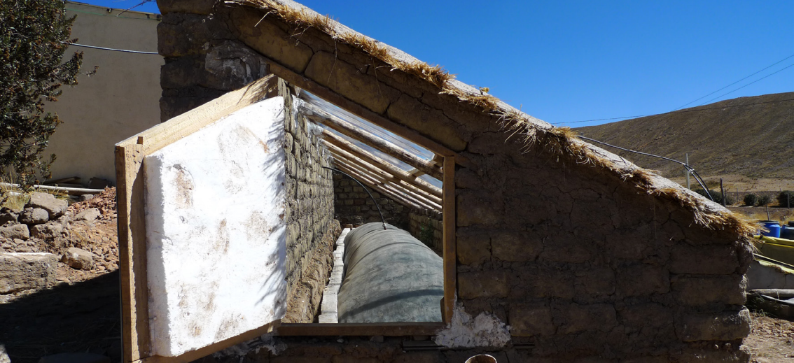
Figura 3: Biodigestor tubular de plástico adaptado a clima frío (Bolivia) .
