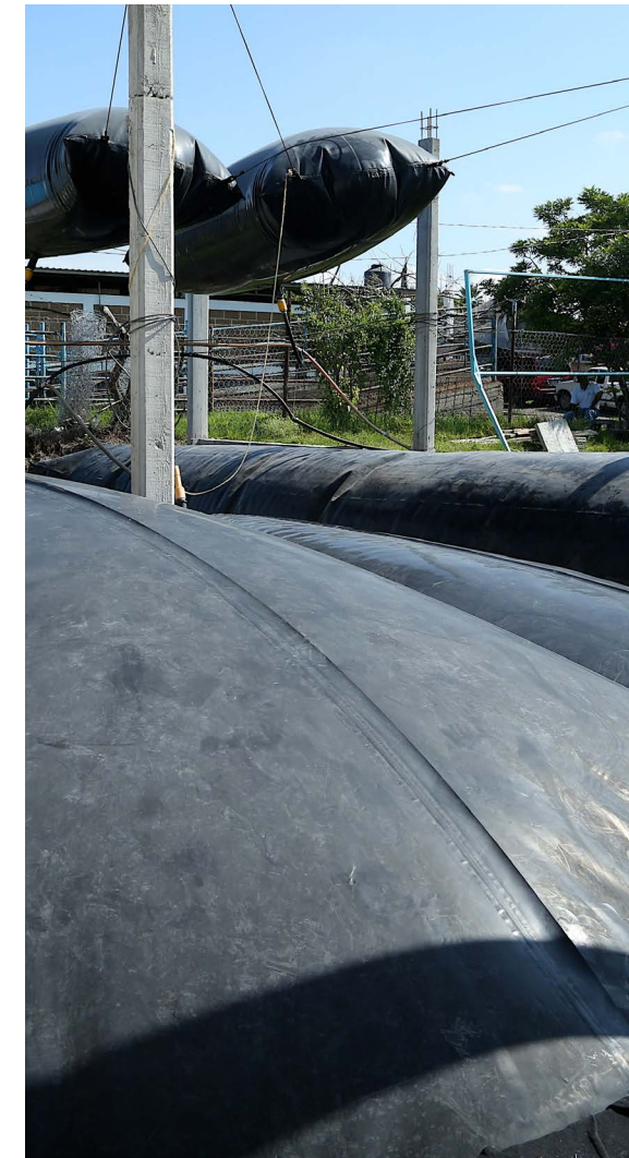
Figura 2: Biodigestores tubulares de plástico (Ecuador) (arriba izquierda), de geomembrana de polietileno (México) (derecha), de geomembrana de PVC (Costa Rica) (abajo izquierda)
