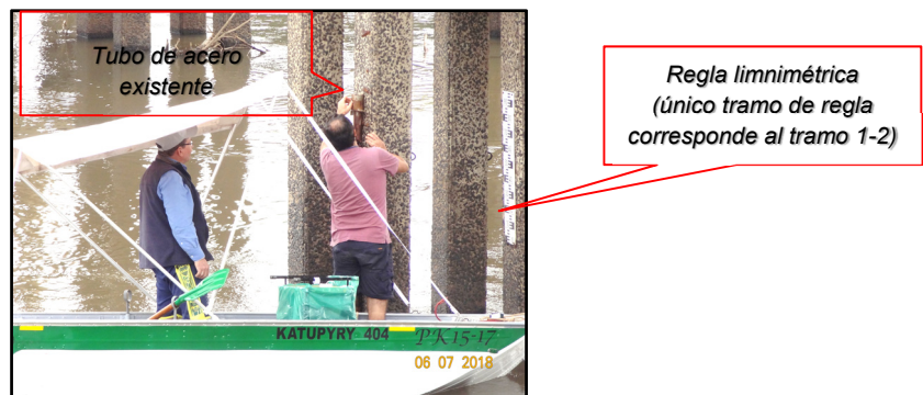
Ilustración 5: Montaje del limnímetro electrónico en el tubo existente.
