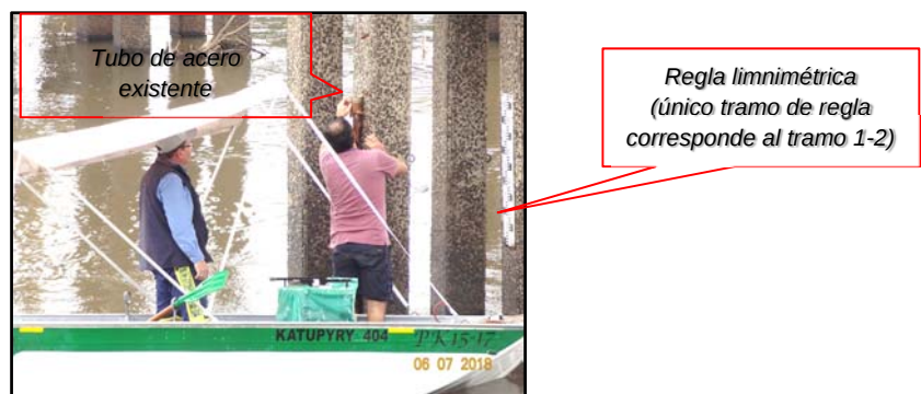
Ilustración 5: Montaje del limnómetro electrónico en el tubo existente.
