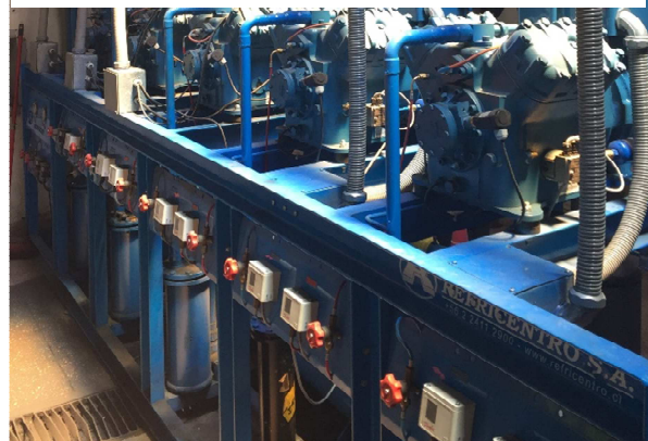
Central de compresores de SADEMA 3
