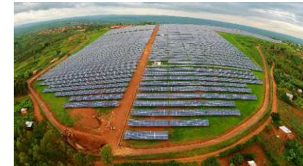
Client Gigawatt Global, une installation solaire 7,5MW au Burundi
