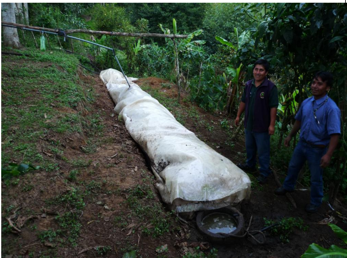
Figura 11: Biodigestor tubular plástico instalado en el Valle de Intag por la ACAI en 2013 (Imbabura)
