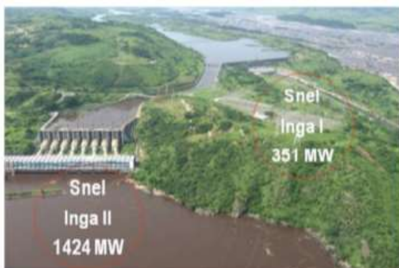
Figure 66—: Une centrale hydroélectrique ; source :
